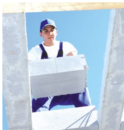
Ukládání stropních vložek
